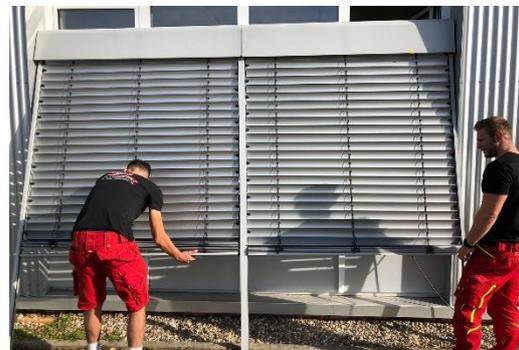
Abbildung 12: Montage Lamellenstoren
