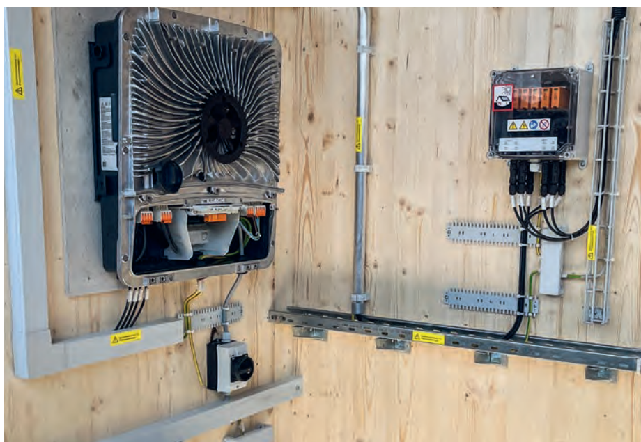
Im Fachkurs «Solarmonteur 2» werden neben der Auffrischung der bisherigen Inhalte Themen wie «Montage von Kabelkanälen und Trassen» oder die «Montage des Wechselrichters» behandelt.
