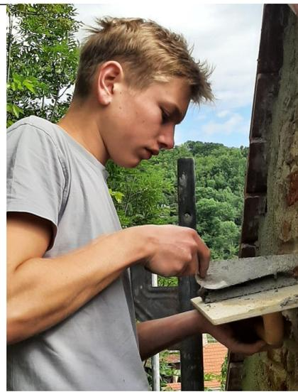
Abbildung 14: Oliver mörtelt die Ortziegel ein
