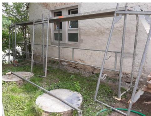
Abbildung 7: Erstellen eines Gerüstes
