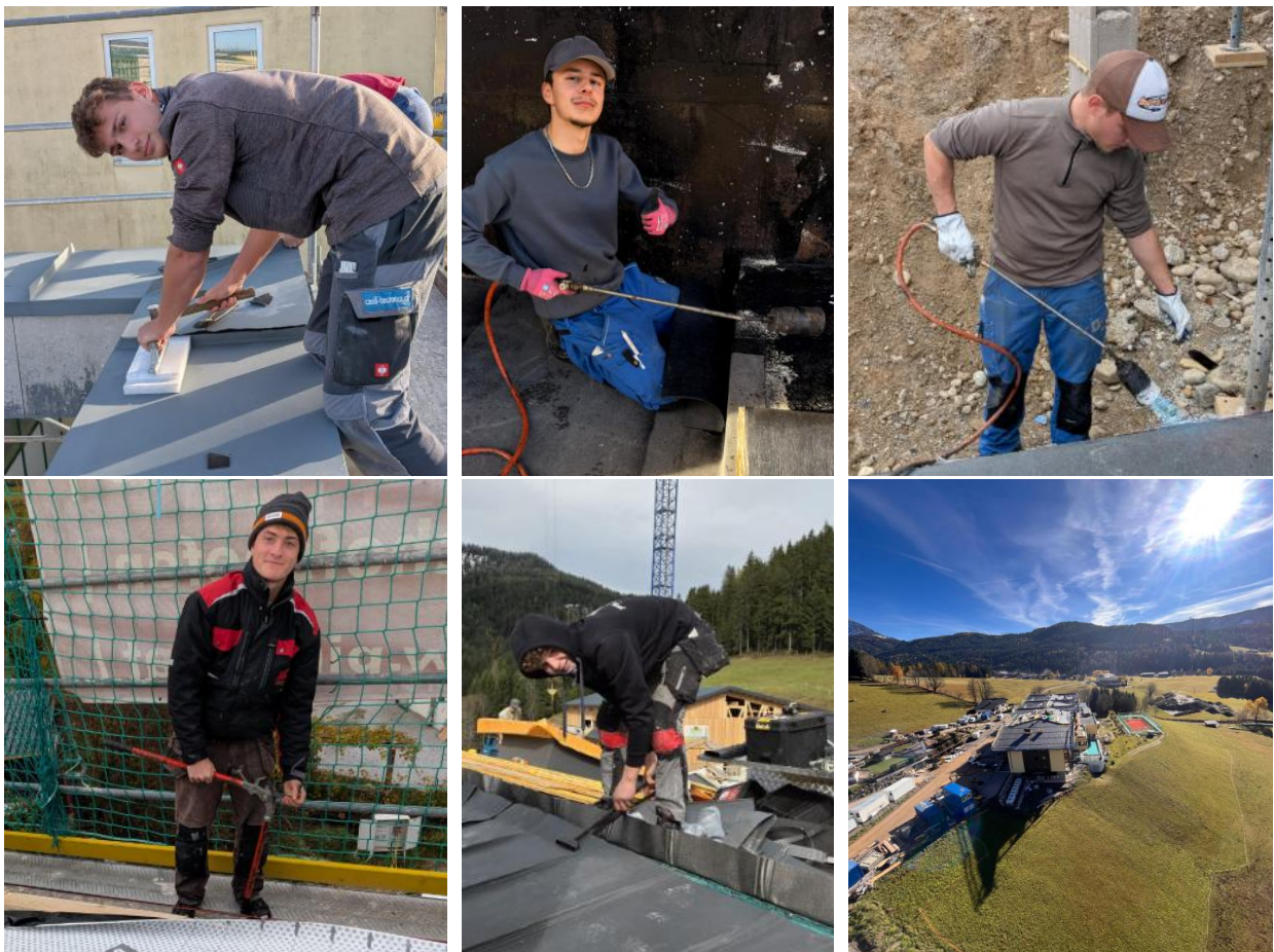
Abbildung 12: Verschiedenste Arbeiten auf den Baustellen in der Region Salzburg
