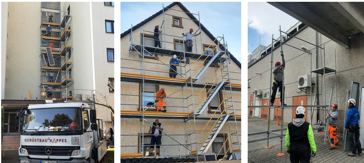
Abbildung 6: Motivierte Lernende auf bei der Demontage von verschiedenen Gerüsten
