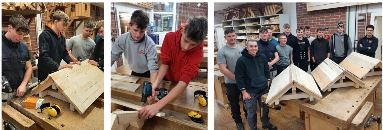
Abbildung 6: Endmontage des Dachstuhls.
