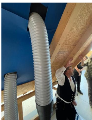
Abbildung 27: Erarbeiten von verschiedenen Durchdringungsarten der Kabel durch die Dachsysteme
