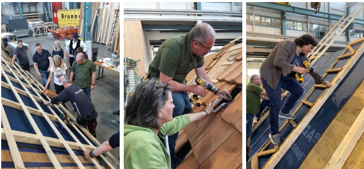
Abbildung 4: Eindeckung einer Dachfläche
