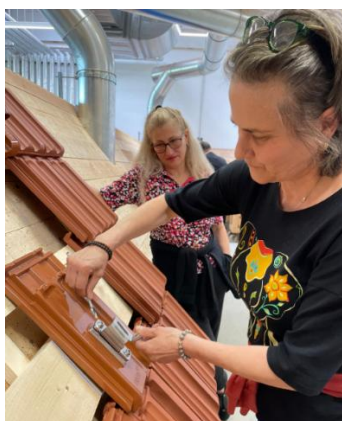
Abbildung 27: Erarbeiten von verschiedenen Durchdringungsarten der Kabel durch die Dachsysteme
