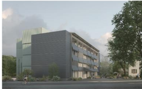
Das neue Kompetenzzentrum Gebäudehülle entsteht an der Ecke Bahnhofstrasse / Sonnenhügelstrasse in Uzwil. Es nutzt Teile der bestehenden Gebäude dort weiter und schonst so Ressourcen. Als Plusenergiehaus erzeugt es mehr Energie, als es verbraucht.
