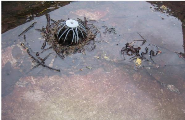
Mangelnder Dachunterhalt mit falschem Kieskorb
