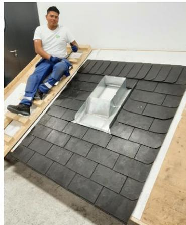
Abbildung 1310: Reny glücklich mit der Faserzement-Doppeldeckung
