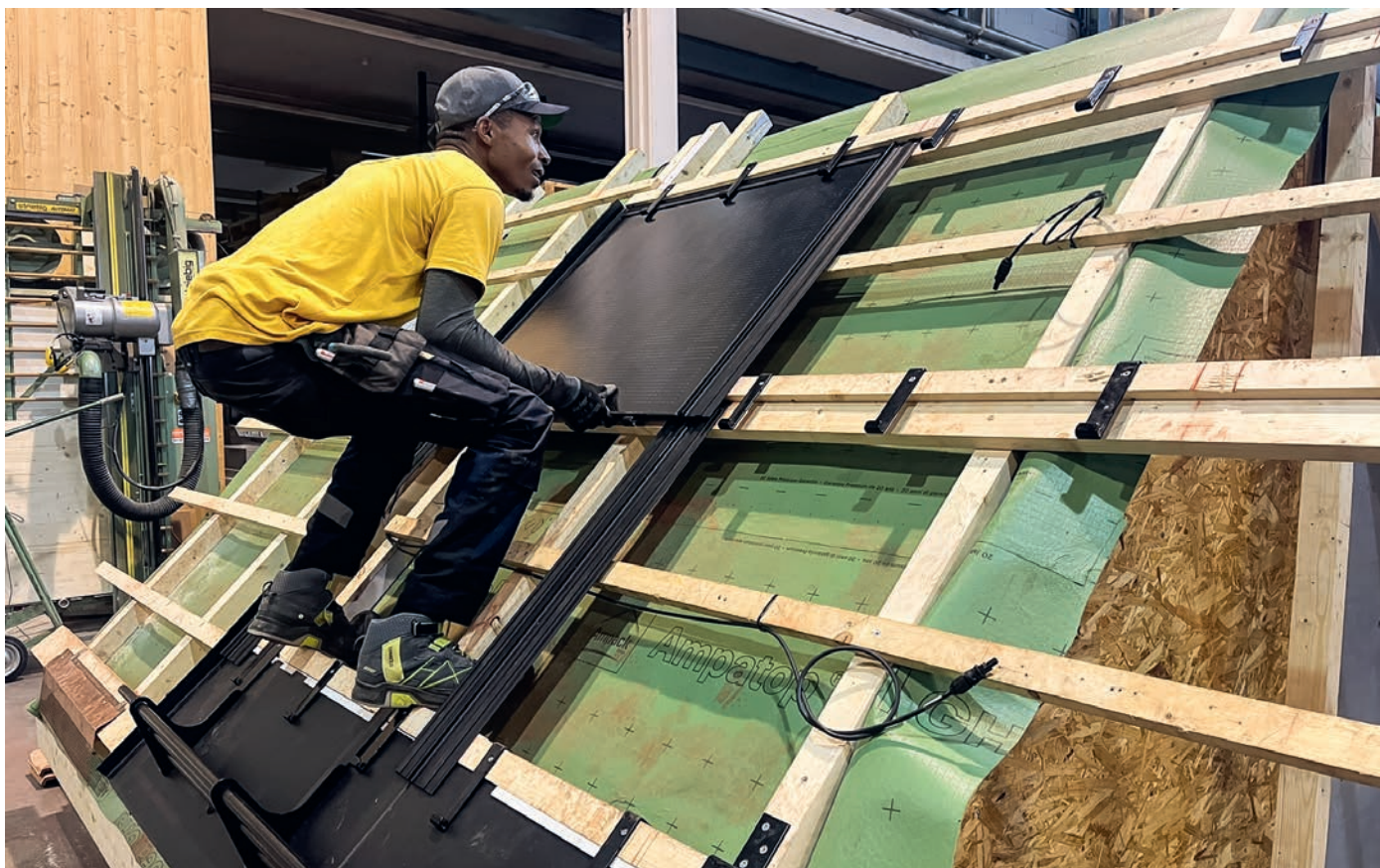
Einhängen von Photovoltaik-Modulen.
