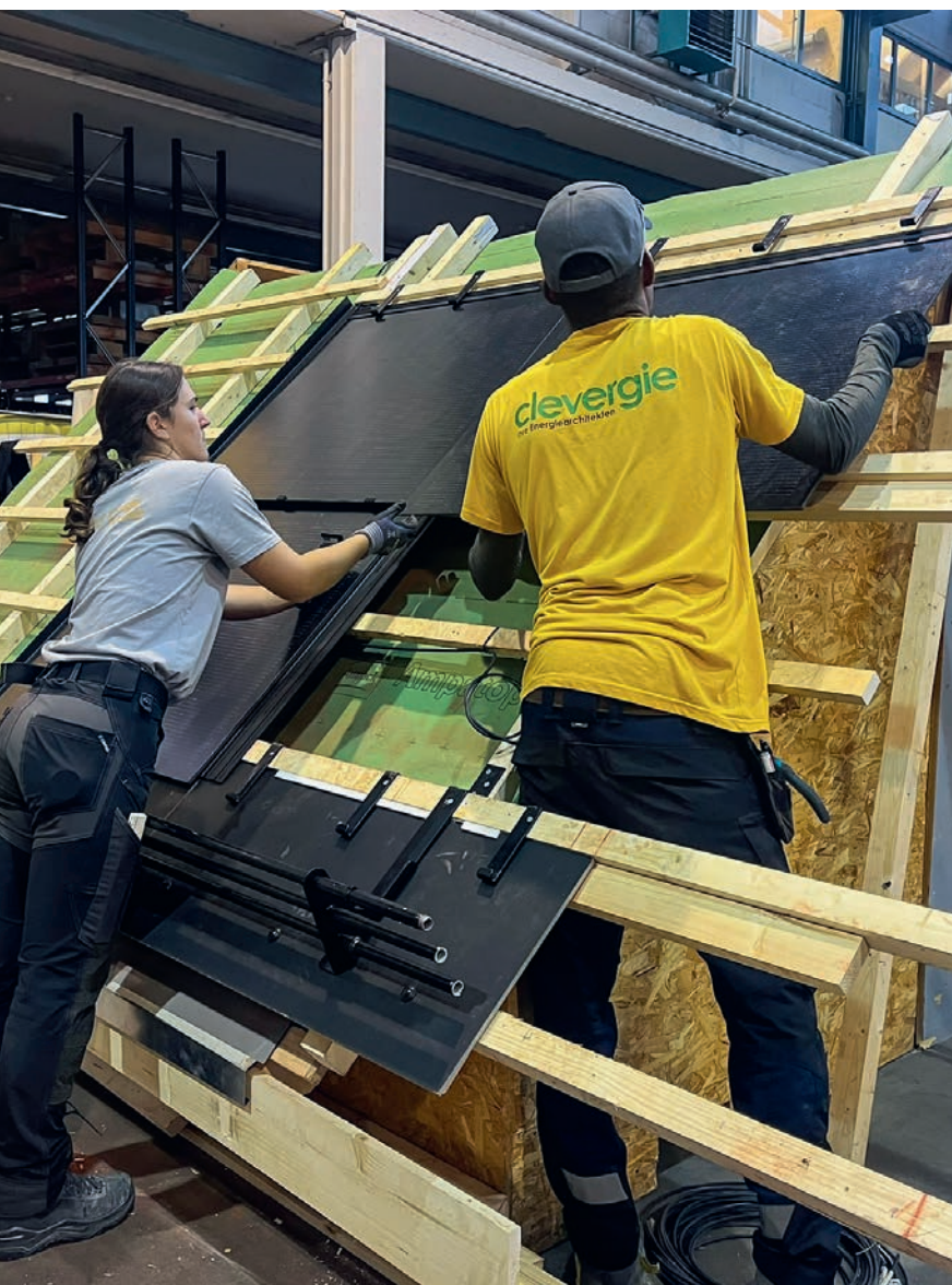
Einhängen und Verbinden von Photovoltaik-Modulen.
