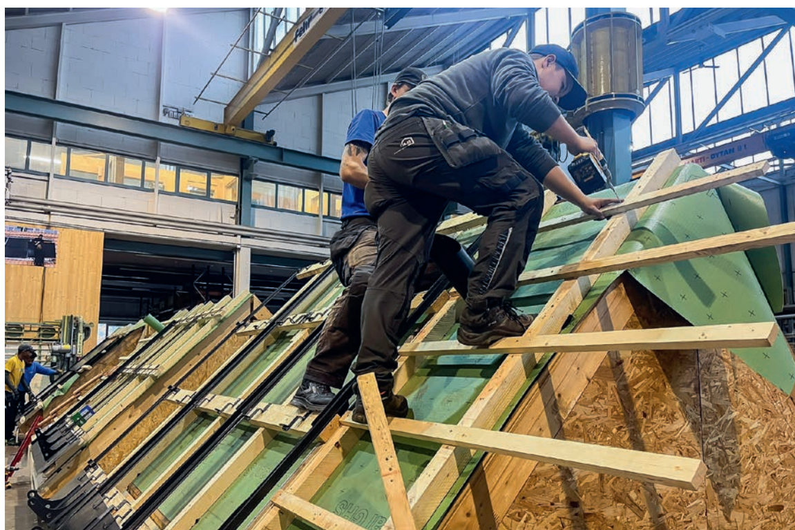
Erstellen von Verlegeunterlagen.
