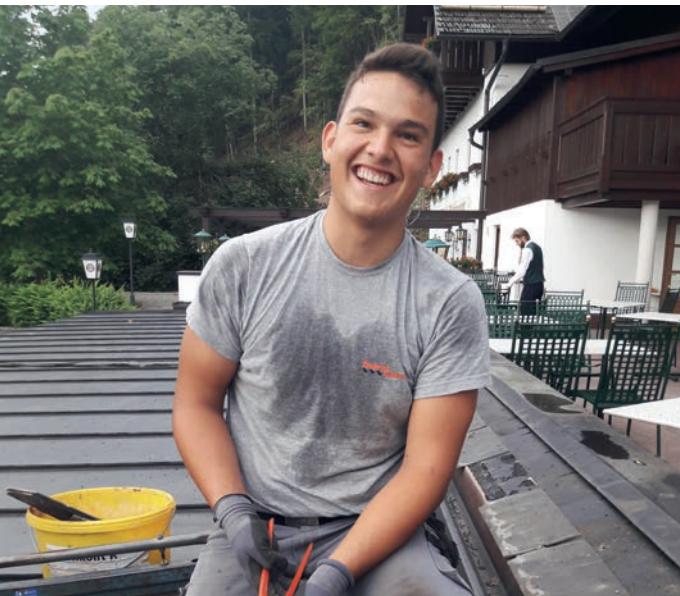
Lars Kühni bei der Dachreparatur.
